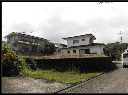
敷地前道路(北側)から見た写真
