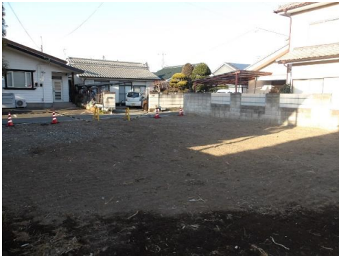
南西角から見た敷地 既存建物を解体し更地となった
