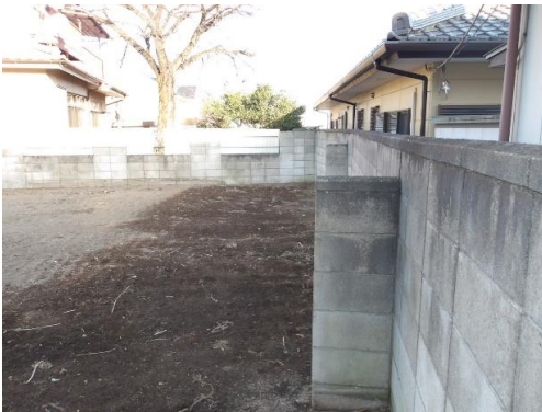
南西角から見た敷地南側部分
