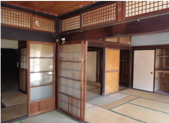
和室が四間、合わせて24.5畳あり 古民家ならではの襖や欄間が取付けられている
