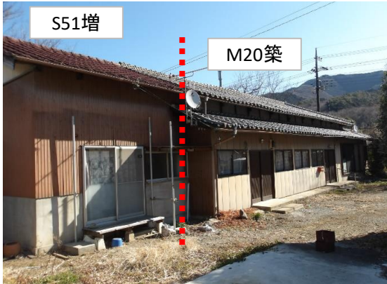
建物外観写真 建物手前、赤い瓦部分が増築箇所
