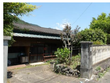
敷地入口付近
