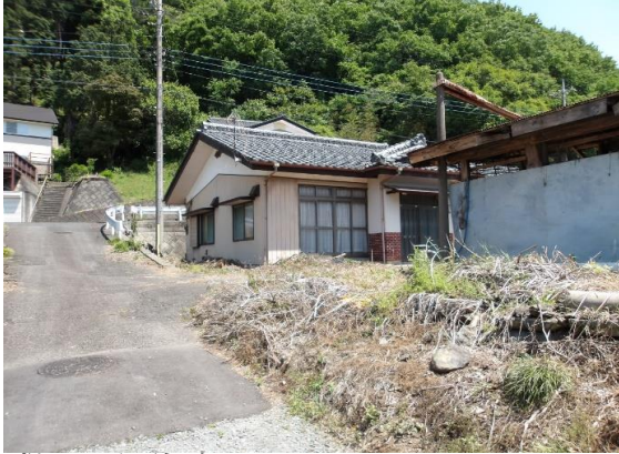
敷地前道路 2項道路となり狭あい協議が必要
