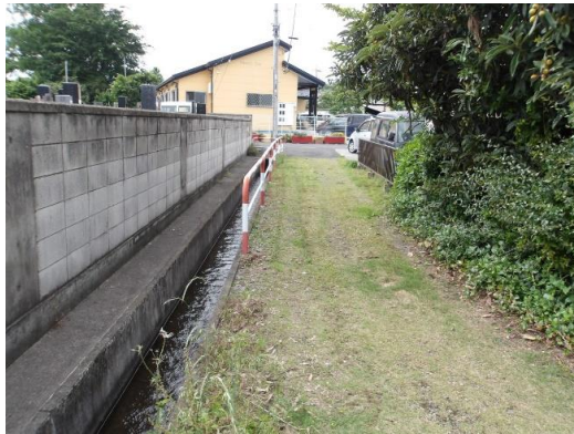
敷地側から見た道路と水路
