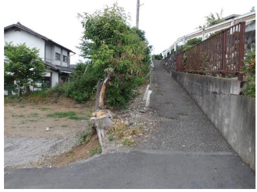
敷地北側の道路は指定外道路
