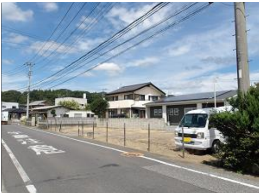
敷地前道路に消火栓あり
