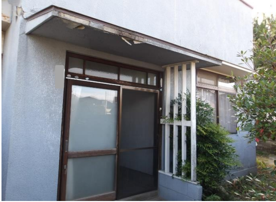
玄関エントランス ガラス引き戸がレトロな印象
