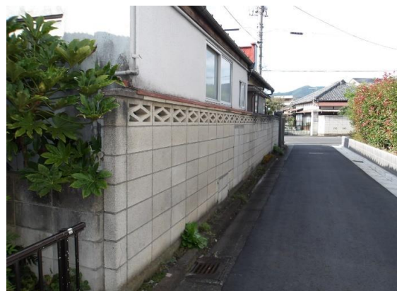
敷地東側の道路 2項道路による狭あい協議が必要
