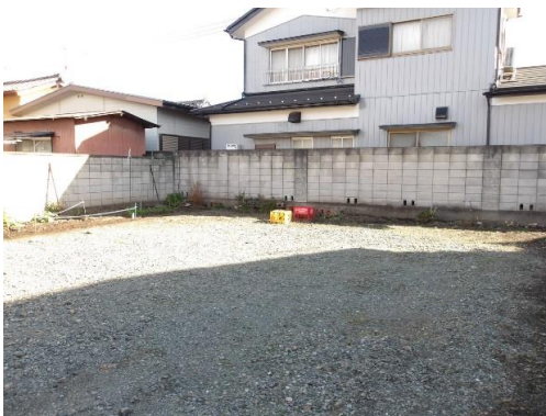
西側から見た敷地東側
