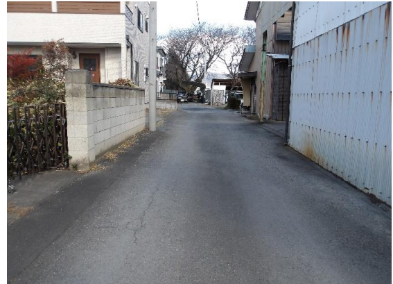
敷地前道路(南東側) 私道の2項道路は持分あり 狭あい協議必要
