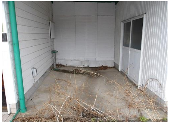
居宅脇は小型車用のガレージ EV充電可、外水道あり 写真右は倉庫
