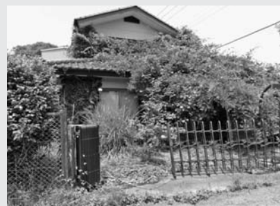
(市内の空き家)
