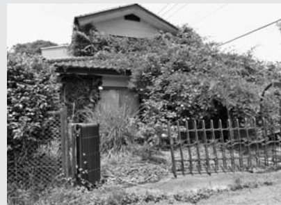
(市内の空き家)
