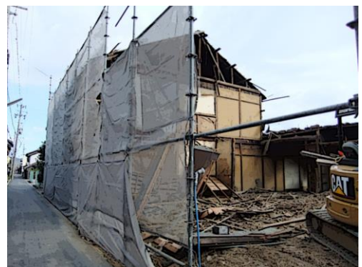
解体される歴史的建造物（他都市）
