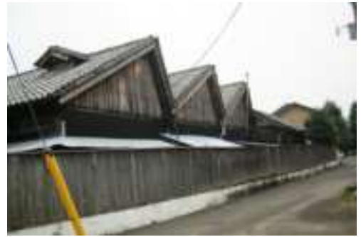
ノコギリ屋根工場
