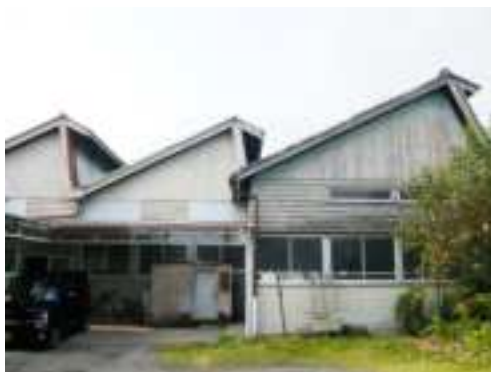
ノコギリ屋根工場
