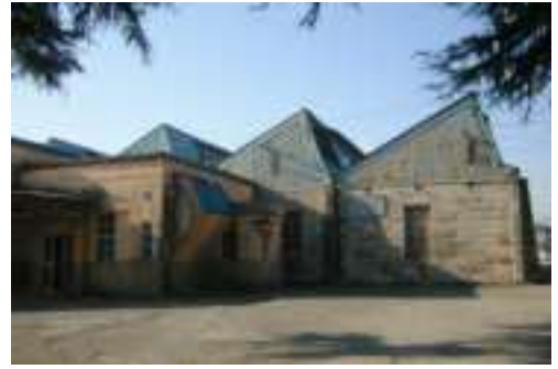
ノコギリ屋根工場
