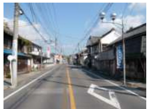
桐生新町伝建地区の町並み
