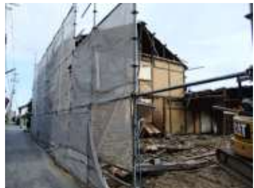
解体される歴史的建造物（他都市）
