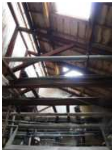
小池染色 (ノコギリ屋根工場内部)
