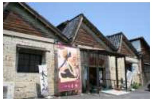
ノコギリ屋根工場
