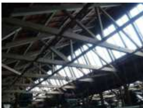
北側に採光窓のある工場内部
