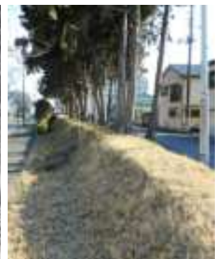
現在も残る当時の土手の一部と樹木
