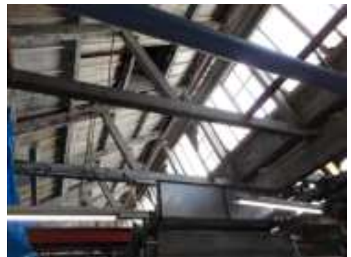
ノコギリ屋根工場内部
