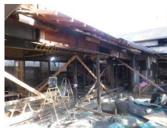
旧眞尾邸宅整備工事の様子 (R4.11)
