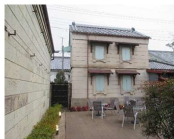
特定物件修繕後
