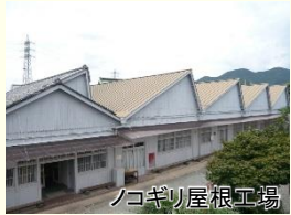
ノコギリ屋根工場
