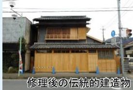
修理後の伝統的建造物
