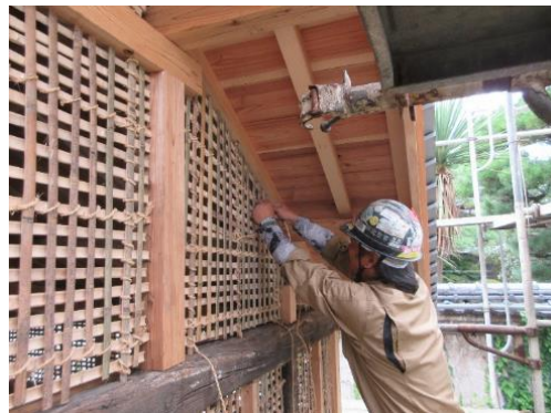
土壁下地修理状況
