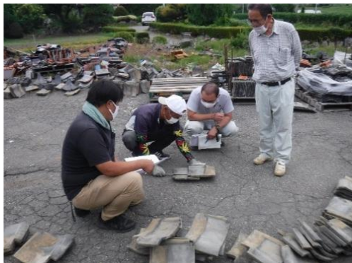
既存瓦を使用するための選別状況
