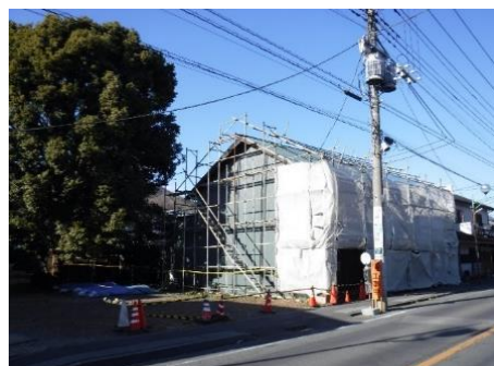
整備対象建物
