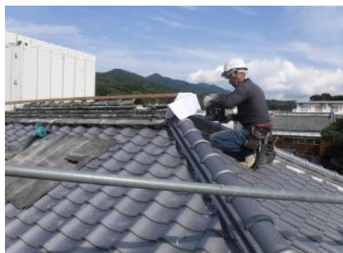
瓦葺き施工状況
