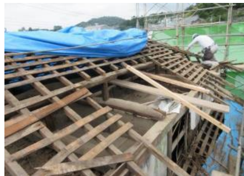
葺下地修理状況
