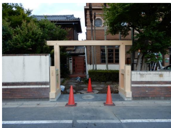
旧金谷家主屋の飲食及びギャラリーとしての活用のための保存修理工事を実施。事務局の設置及び修理の指導を行う。
