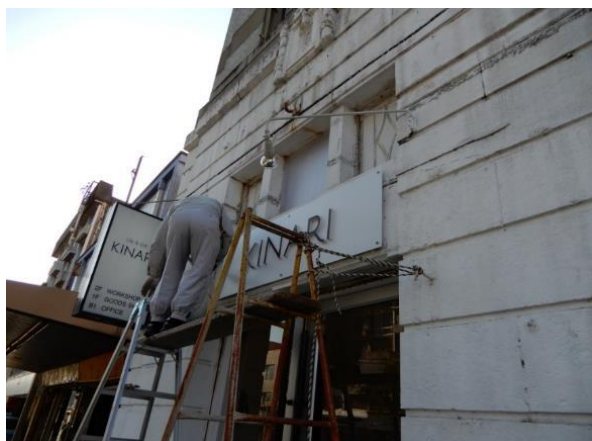
東日本鉄道文化財団の助成を受け登録有形文化財金善ビルの保存修理工事を実施。事務局の設置及び修理の指導を行う。
