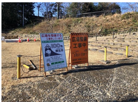
桐生が岡公園下広場(藤棚広場)整備工事現
