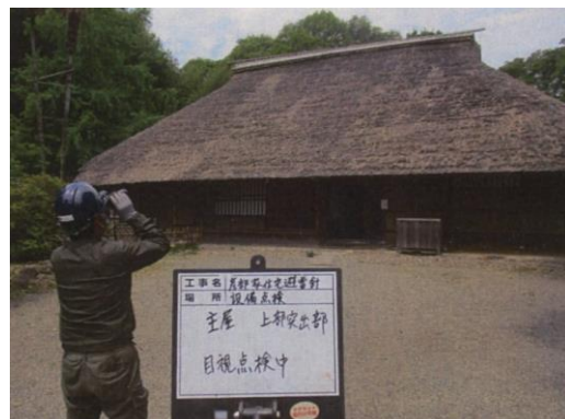
彦部家住宅 避雷設備保守点検
