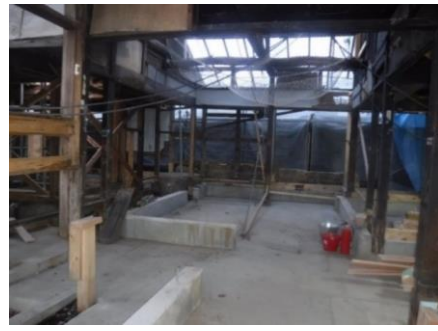
工事状況 内部
