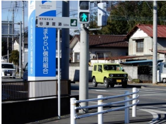
谷津館跡 導入板修繕
