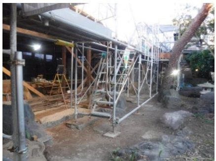
工事状況 外部
