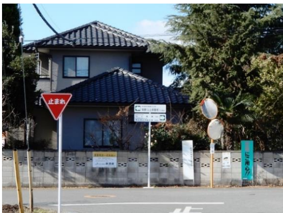
山上多重塔、山上城跡、常広寺の弁財天堂 導入板修繕
