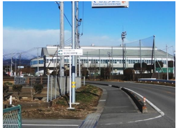
常広寺の弁財天堂 導入板修繕
