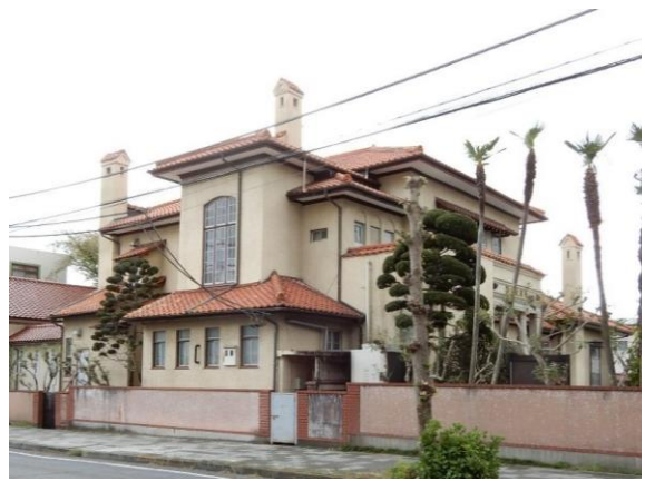
桐生倶楽部会館 北側外壁等修繕
