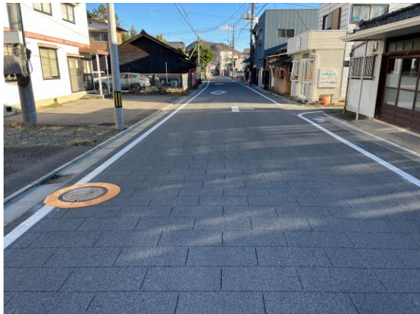
道路美装化工事 (横町通り)
