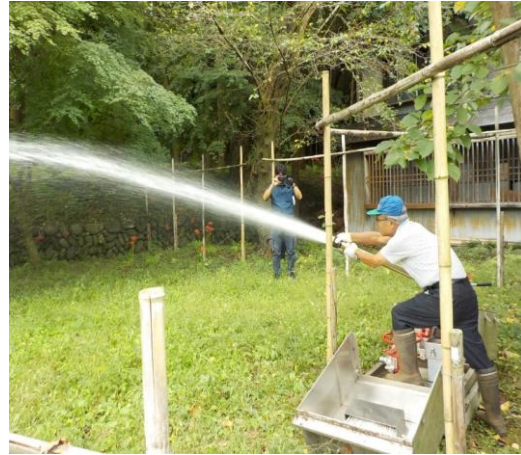
彦部家住宅 消防設備点検の様子
