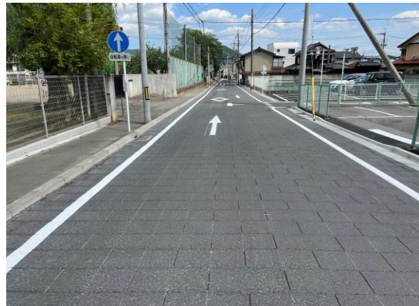
道路美装化工事 (ゑびす通り)
