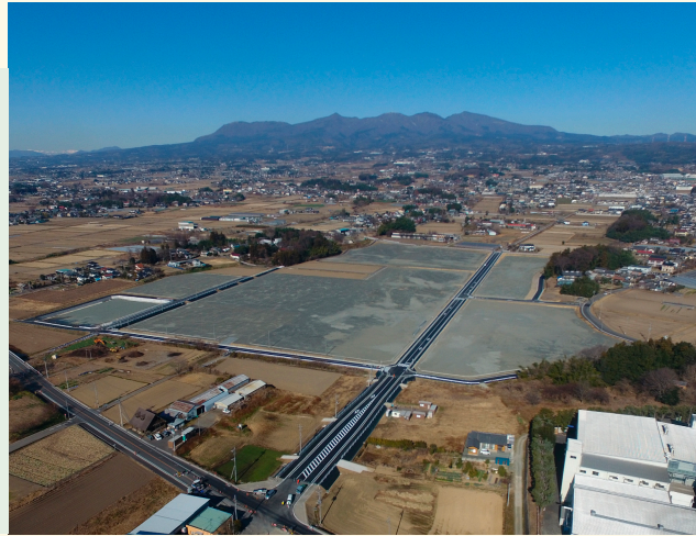
桐生武井西工業団地
