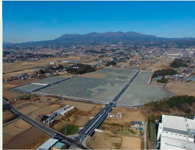
桐生武井西工業団地
