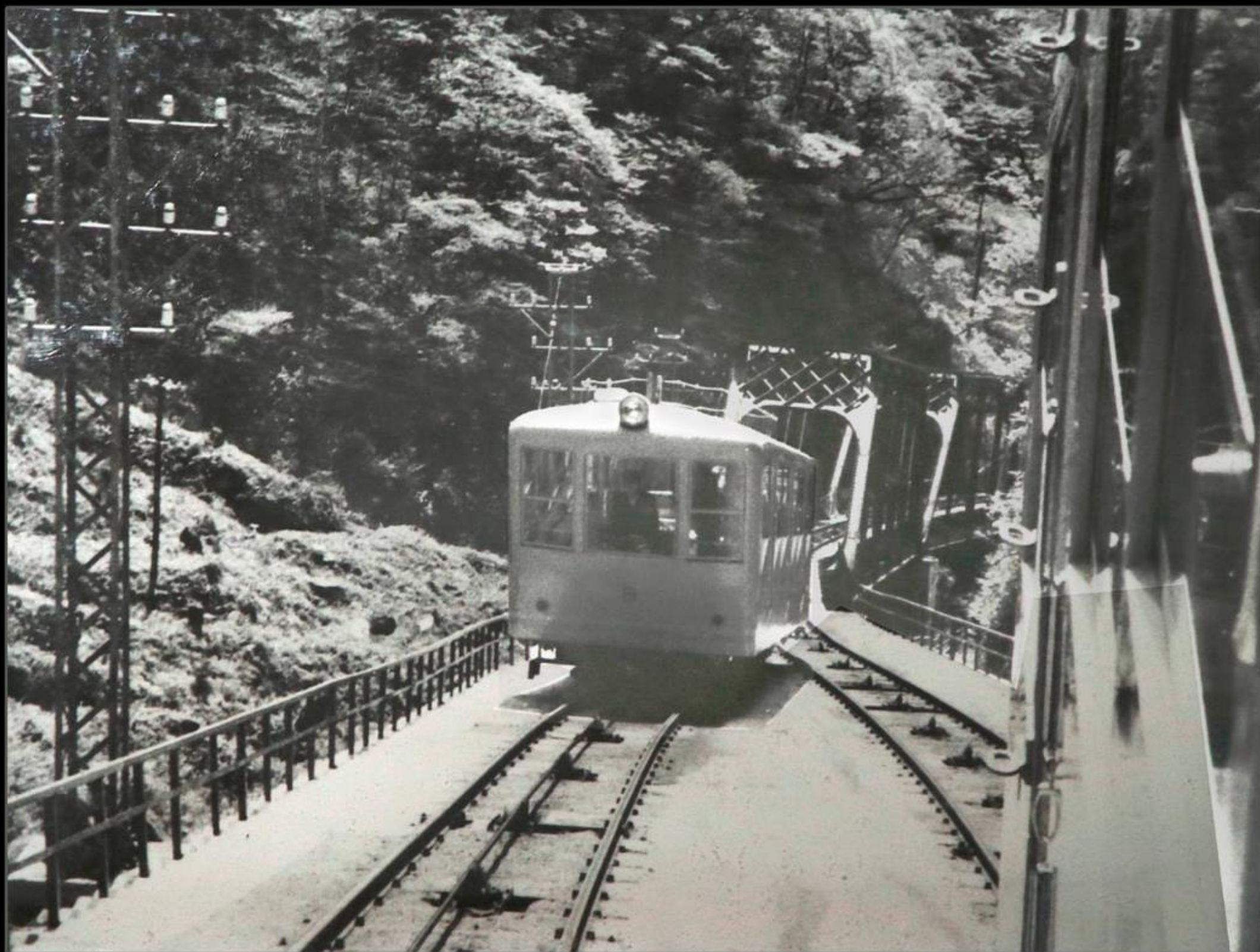
旧黒保根村の利平茶屋駅を出発し、交差部に入り赤城山頂駅へと向うケーブルカーの写真。線路中央から車両下へ続く駆動用ケーブルが見える。
