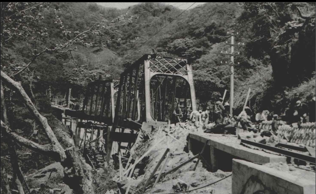
写真左：工事中のロンドンブリッジの鋼材を使用した鉄橋。写真右：現在の草木に埋もれた橋脚跡付近
