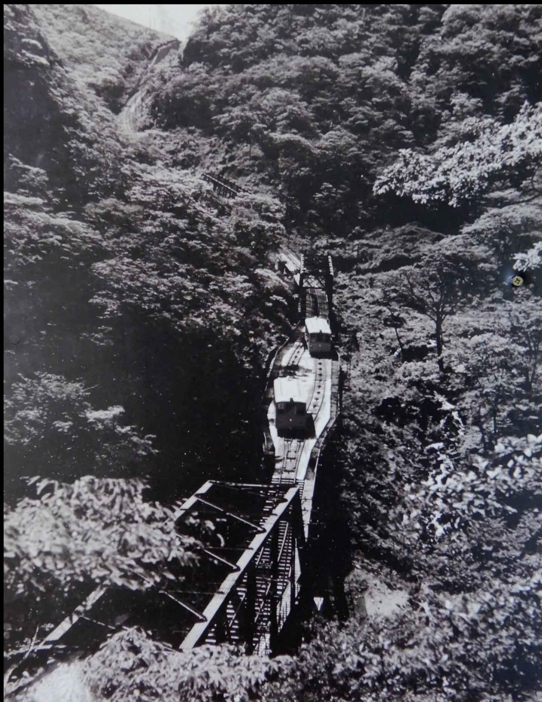
左写真：営業時のケーブルカー下りと上りの交差部。写真右：交差部の前後に上りと下りのケーブルカー。
