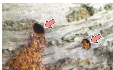
フラス孔の確認
