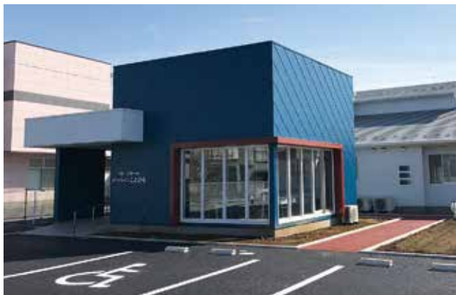
平成30年度に設置したグループホーム
