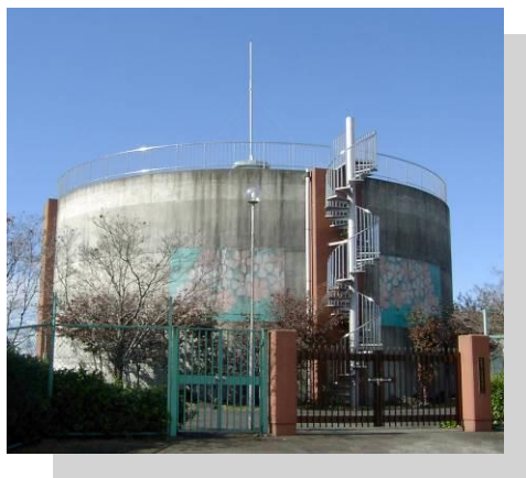
新里第 1 配水場
