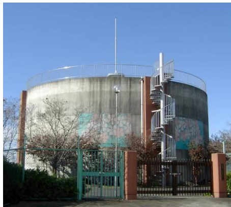
新里第 1 配水場
