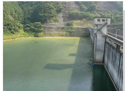
桐生川ダム堰堤
