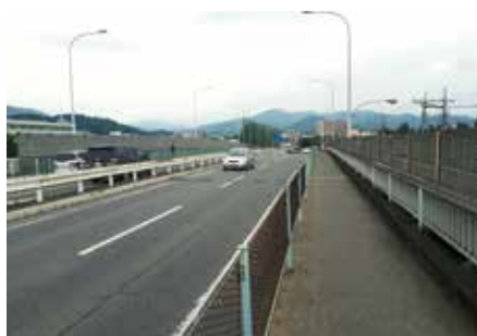
「創造」橋梁長寿命化（桐生大橋）
