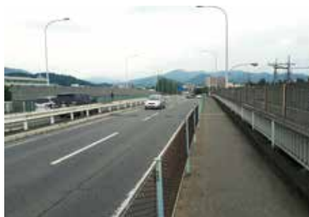
「創造」橋梁長寿命化（桐生大橋）
