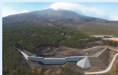
H30片蓋川第二砂防堰堤工事
