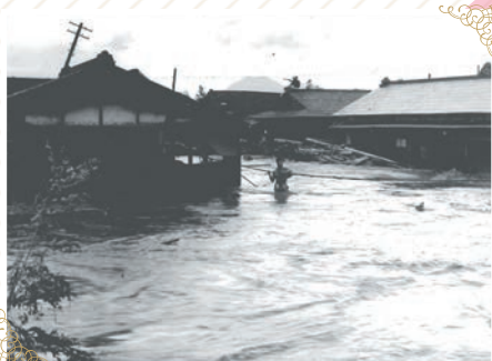
キティ台風による桜木町通りの 被害状況(昭和24年)
