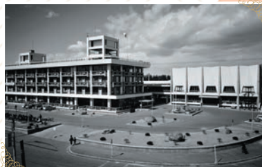
新市庁舎落成(織姫町)(昭和40年)
