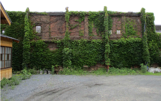
旧北川織物のレンガ壁
