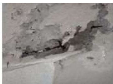
屋上防水の補修
