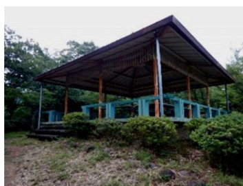
鉄部の全面塗装
