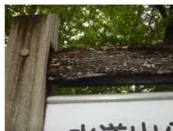
木部の防腐処理
