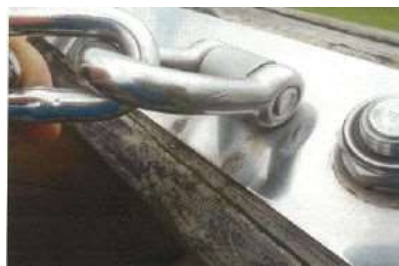
吊り金具の交換
