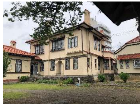
建物外観（庭園から）
