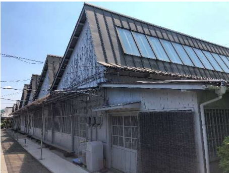
旧鋸屋根工場（外観）
