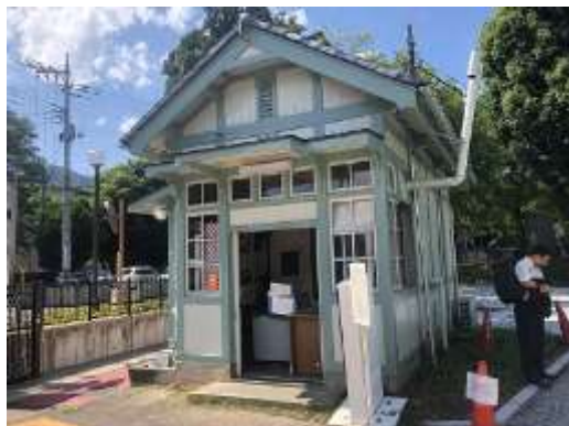
写真 群馬大学工学部守衛所
