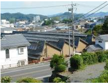
建物遠景（北より）
