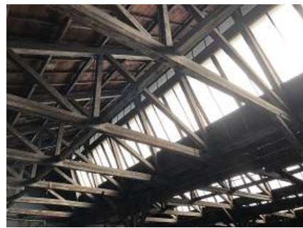
鋸屋根内部より
