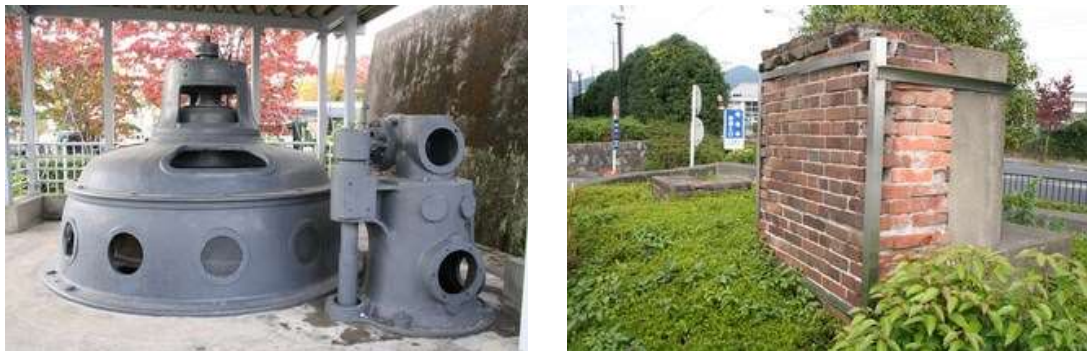
図 15-日本織物株式会社発電所跡及び煉瓦積遺構
