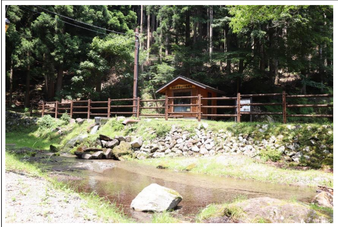
小水力発電所
