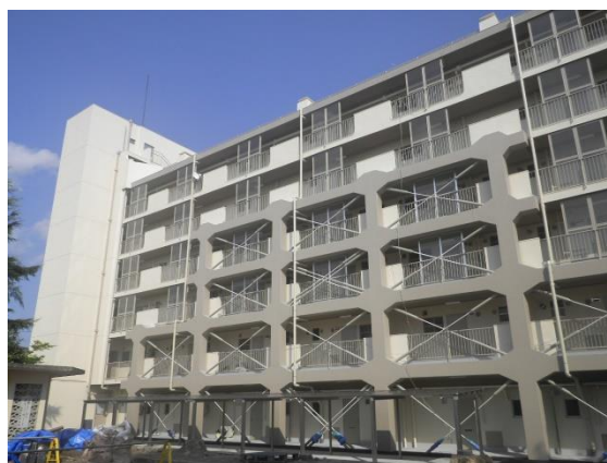
耐震改修（浜松町1丁目団地）
