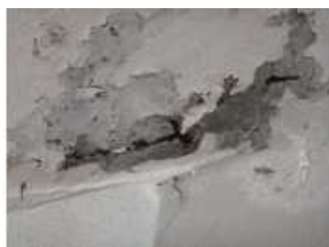
屋上防水の補修
