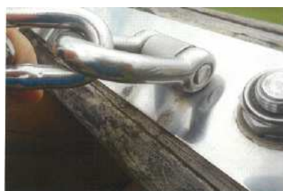
吊り金具の交換
