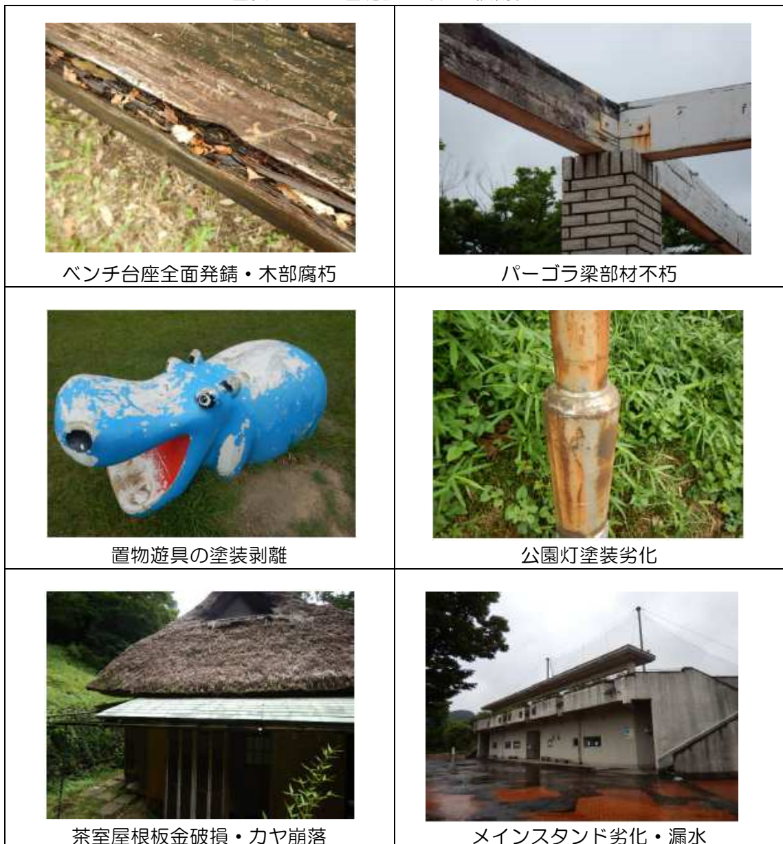
図表 1 8 公園施設の劣化・損傷状況
