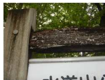
木部の防腐処理
