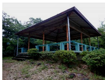
鉄部の全面塗装
