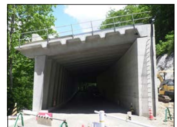
【スノーシェッドの整備】
