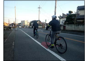
【矢羽根型路面表示の整備】
