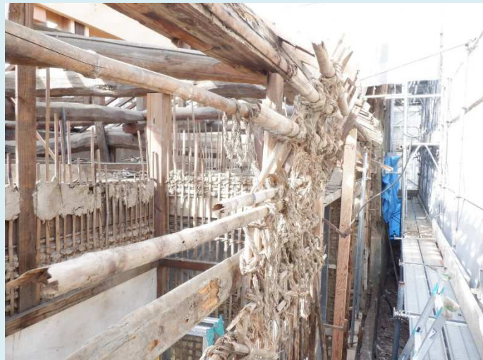
北側外壁状況
