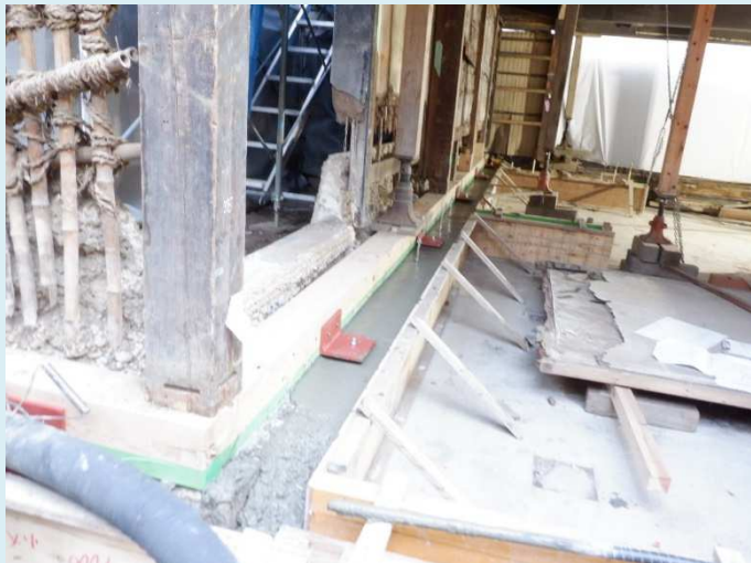
基礎コンクリート打設中
