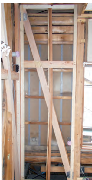
筋かいの新設
