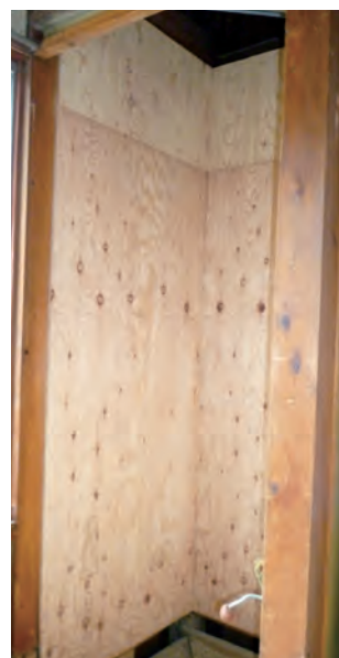
構造用合板による補強
