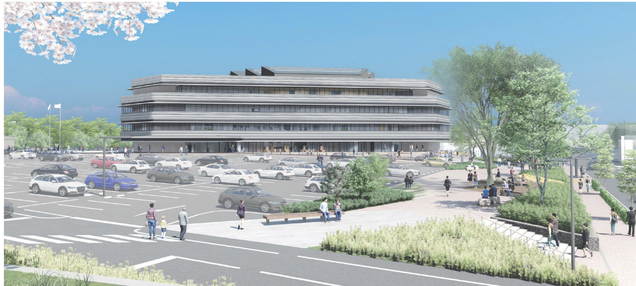
旧織姫神社から新本庁舎を見たイメージ 最上部には自然採光・自然通風を促進するノコギリ屋根を配置
