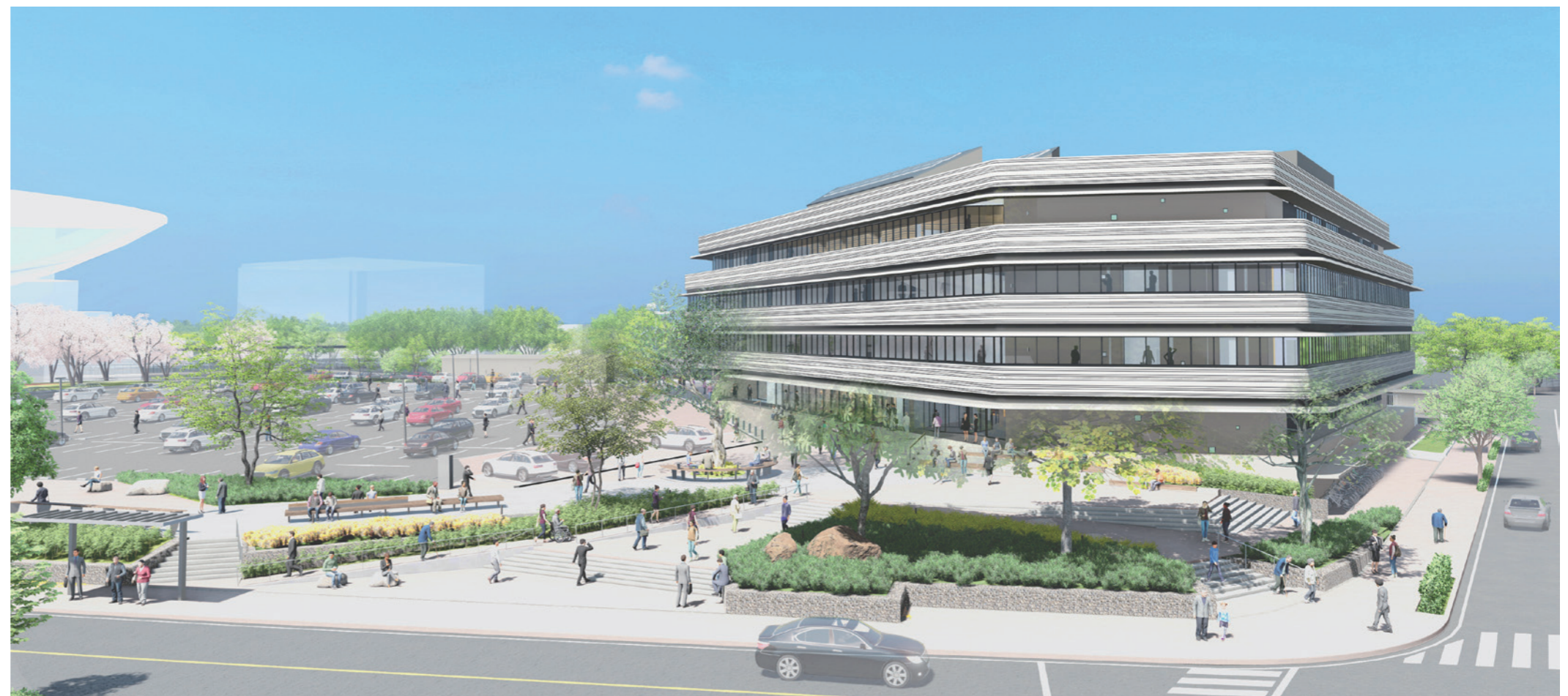
新川橋通りから新本庁舎エントランスを見たイメージ 日射遮蔽効果の高い庇と横連窓により構成されるシンプルな外観
