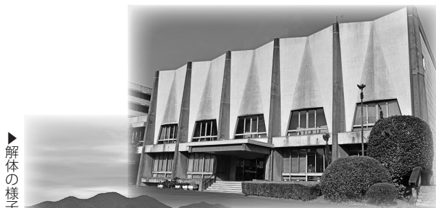
▲解体前の議事堂
